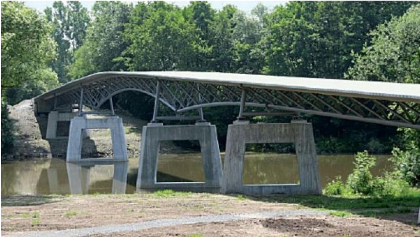
Bridge Gärtnersplatz in Kassel (Germany)
